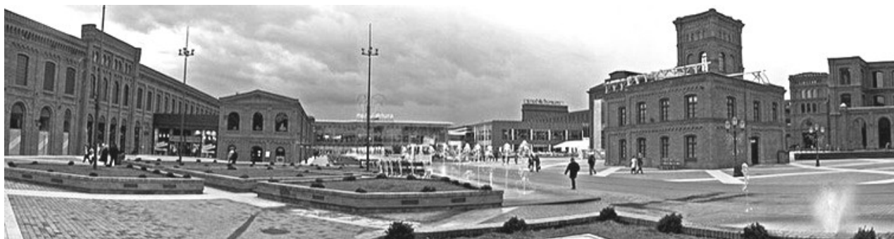
Рис. 1. Перепрофилированные фабричные здания в г. Лодзь, Польша
