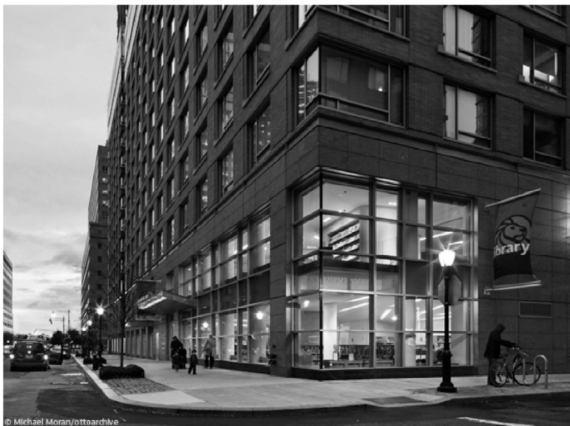
Рис. 6. Публичная библиотека Battery Park City – Нью-Йорк, США. 1100 Architect. 2010. Общий вид фасада библиотеки
