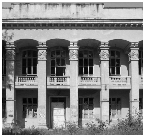
Рис. 2. Административное здание. Балтская дорога, 42
