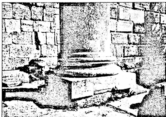
1.2. Баальбек. Смещение оси колонны и разрушения «Малого храма» в результате землетрясения 1956 г.
