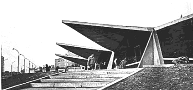
Рис. 2. Фрагмент оболочки 36000x24000 мм .
