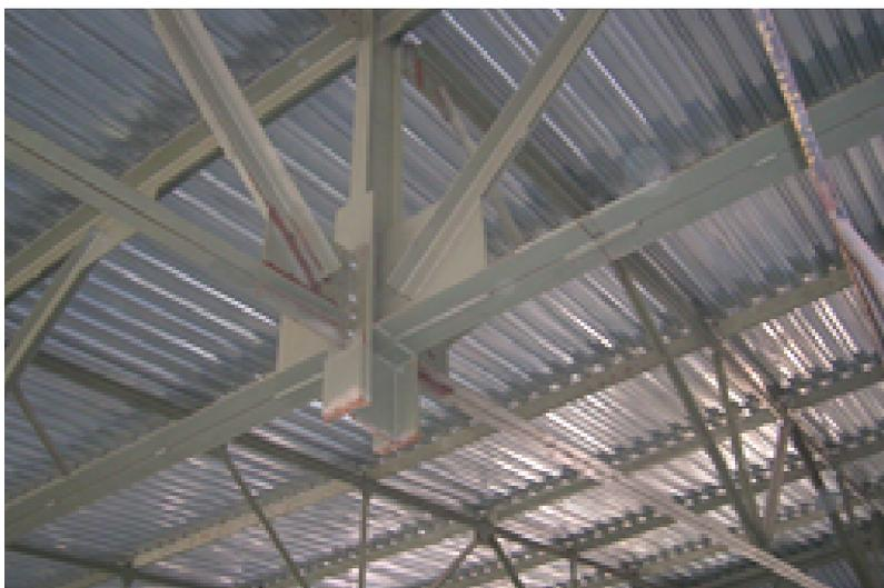
Рис. 1. Ферми с элементами из парных уголков
