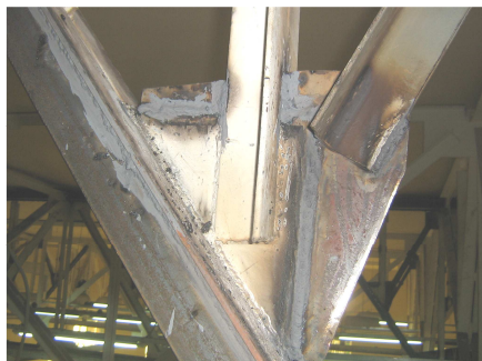
Рис. 5. Узел крепления дополнительных элементов решетки
