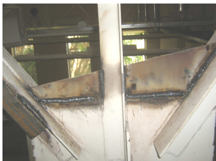
Рис. 4. Наращивание длин сварных швов крепления элементов решетки
