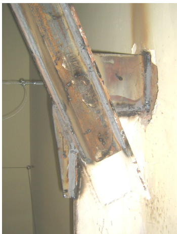
Рис 6. Увеличение сечения стержня опорного раскоса фермы
