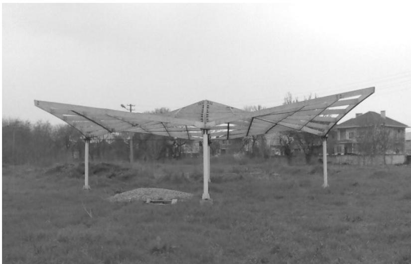
Рис.1 Четырехлепестковая сборная деревянная гиперболическая оболочка.(Одесса 2012)
