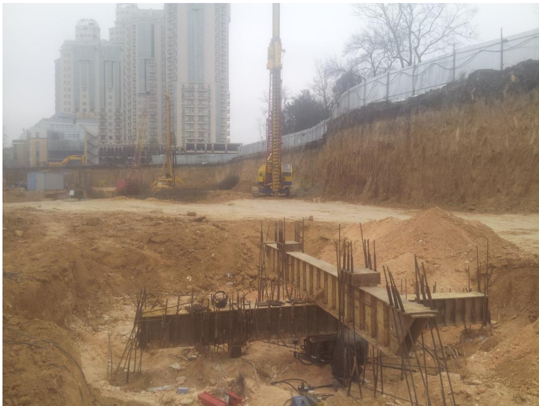
Рис. 4. Фрагмент испытания грунтов буронабивной сваей
