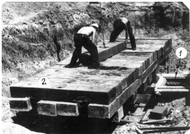
Рис. 1.10. Загрузка опытного фундамента. 1. Прогибомеры для измерений осадки фундамента и перемещений грунтовых марок. 2. Груз – чугунные гири весом 20 \text{ кН}
