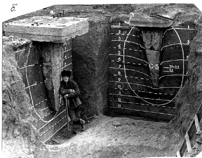
Рис. 5.1. Положение фиксаторов деформаций после окончания испытаний: a) зачистка фиксаторов в основаниях свайных фундаментов; б) фиксаторы в поперечных сечениях одиночных свай.
