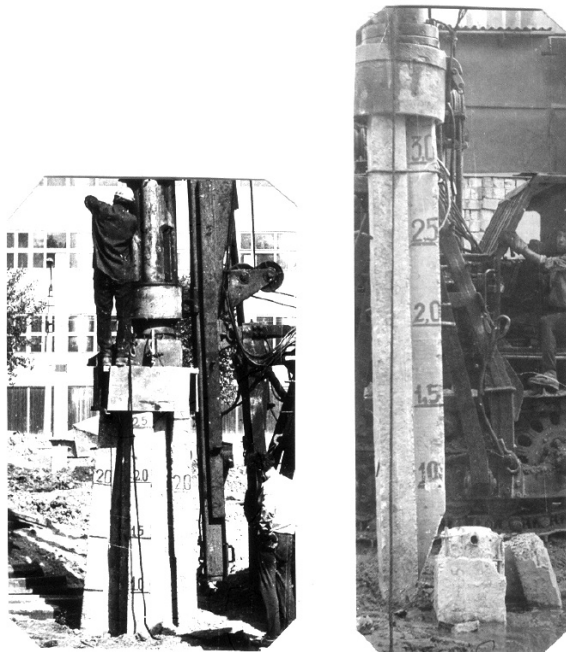
Рис. 5.5. Погружение козловых свай: слева – кустовое «пакетом»; справа – раздельное
