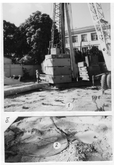
Рис. 4.6. Общий вид фрагмента участка в процессе погружения свай.
