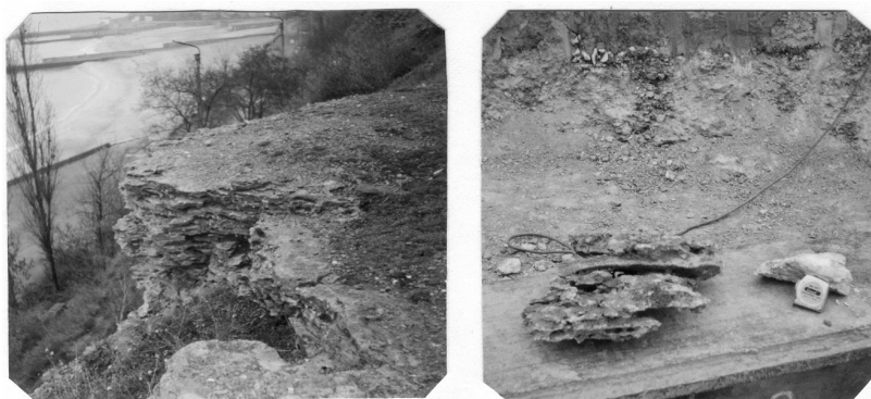
Рис. 4.2. Крупнообломочный кавернозный известняк: а) обнажение у основания склона, примыкающего к участку № 1 по пер. Амбулаторному в г.Одессе; б) отдельные фрагменты крупнообломочного известняка (котлован по ул. Генуэзской № 1)
