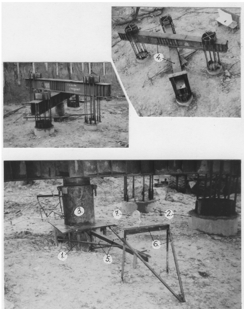
Рис. 4.30. Общий вид стенда для испытания свай. 1. Опытные сваи. 2. Анкерные сваи. 3. Домкрат ДГ-500. 4. Двухбалочный опорный стенд. 5. Выносные консоли. 6. Реперная система
