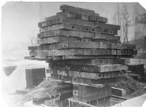
Рис. 5.7. Общий вид фундамента с козловой свай, загруженного чугунными гириями на участке ОПО «Медлабортехника». Вес груза 3,12 МН
