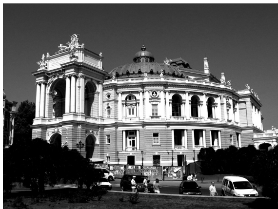
Рис. 6.15. Вид театра после реставрации
