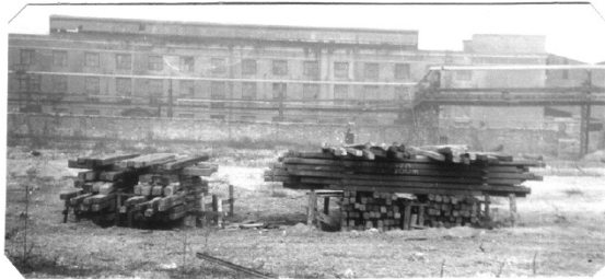
Рис. 5.6. Общий вид фундаментов, загруженных стальными брусьями
