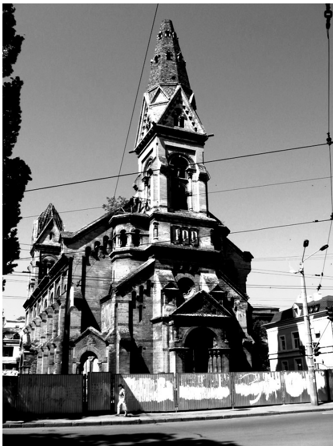
Рис. 6.16. Общий вид кирхи до начала реконструкции
