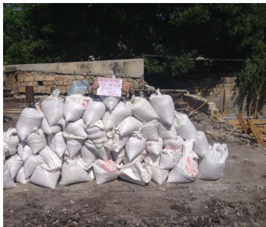
Фото 1. Нагружение плиты покрытия нагрузкой 1800 кг
