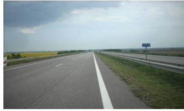
Рисунок 2– Стан ділянки, км 295, 2014 р., значні дефекти відсутні
