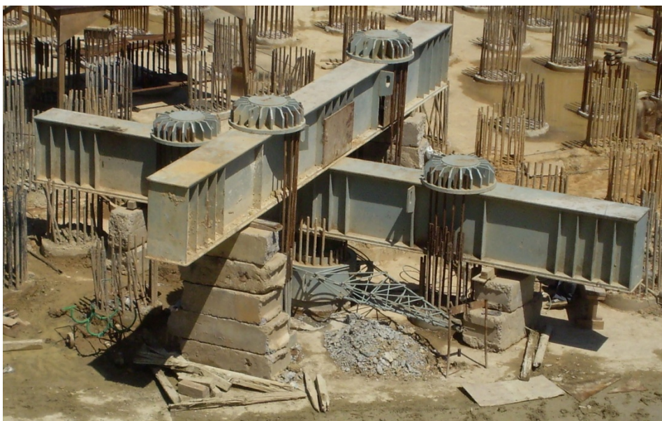
Рис. 1. Испытательный стенд с упорными стальными балками постоянного сечения для испытания буронабивных свай диаметром 1,0 м вдавливающей нагрузкой 600 тс
