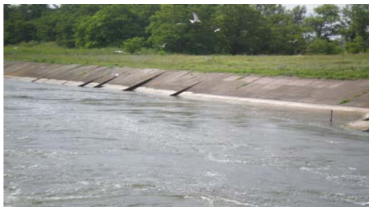
Рис.1 Характерный вид бетонной облицовки Северо-Крымского канала
