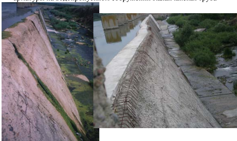
Рис.3. Пример восстановления бетона Софиевской стенки (Николаевская область). Слева – до восстановления, справа – в процессе восстановления
