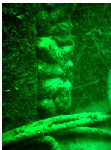
Рис. 3. Заделка зазора между соседними уголковыми блоками бетоном в «мешочках». Стальной трос на поверхности грунта у линии кордона (ПК20+4,5м). /8/
