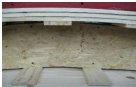
Рис. 4. Фрагмент испытанной балки с разрушенной OSB стенкой
