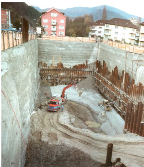
Рис. 1. Сооружение котлована с креплением его стенок
