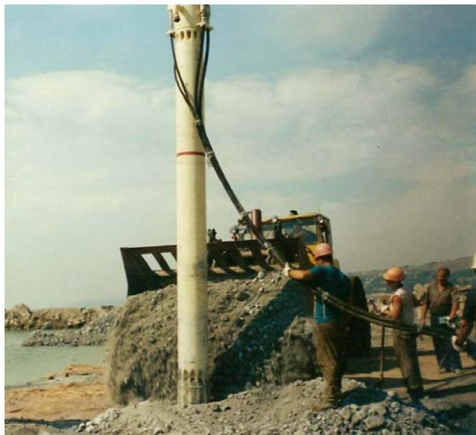
Фото 3. Отсыпка шлака для создания дрены из металлургического шлака комбината Азовсталь
