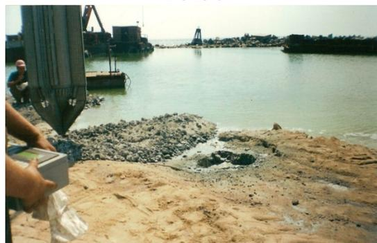
Процесс создания дрены из металлургического шлака комбината Азовсталь выполняемый виброиглой TR-75 фирмы Бауэр в Мариупольском морском торговом порту в 2007 году
