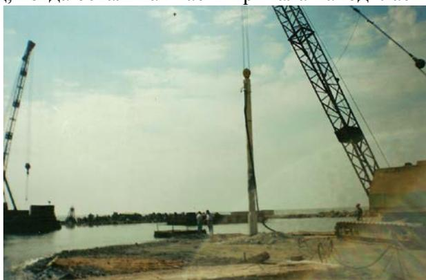
Фото 2. Процесс создания дрены из металлургического шлака комбината Азовсталь выполняемый виброиглой TR-75 фирмы Бауэр в Мариупольском морском торговом порту в 2007 году
