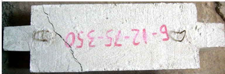
Рис. 5. Общий вид критической трещины
