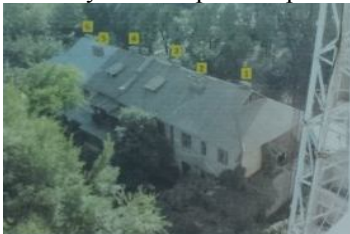
Рис. 2. Исследуемое здание, ул. Разумовского
