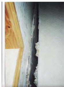
а) щель в стеновом ограждении б) сквозная щель в плитах перекрытия
