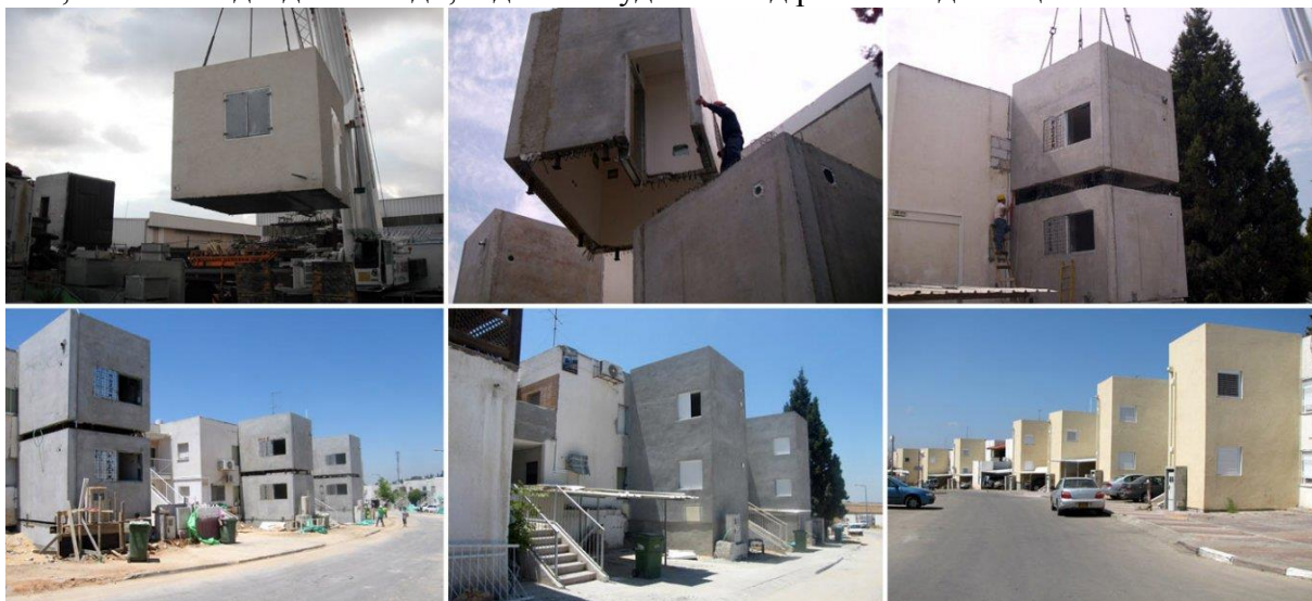
Рис. 1. Встановлення готових укриттів «мамад» у вигляді добудови
