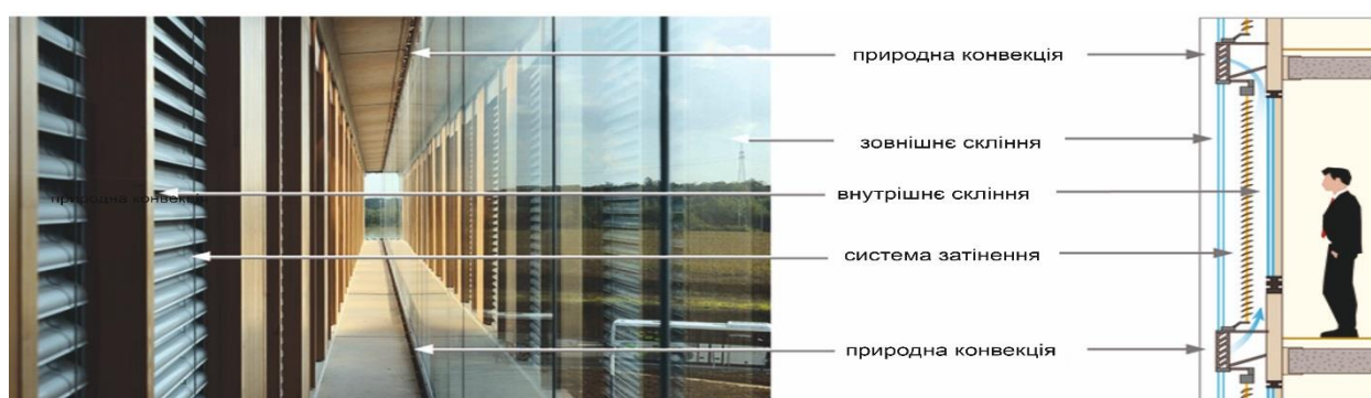
Рис. 4. Конструкція подвійних фасадів
